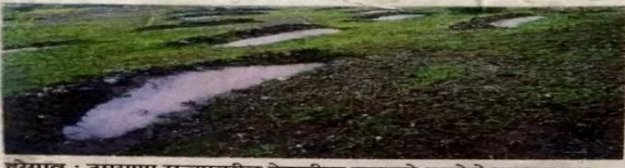
दरेगाव : उमराणा रस्त्यावरील टेकडीवर पाण्याने भरलेले समतल चर.
